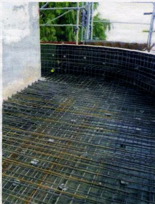
De balkons moesten worden gesloopt en vervangen, omdat ze nauwelijks hun eigen gewicht konden dragen
