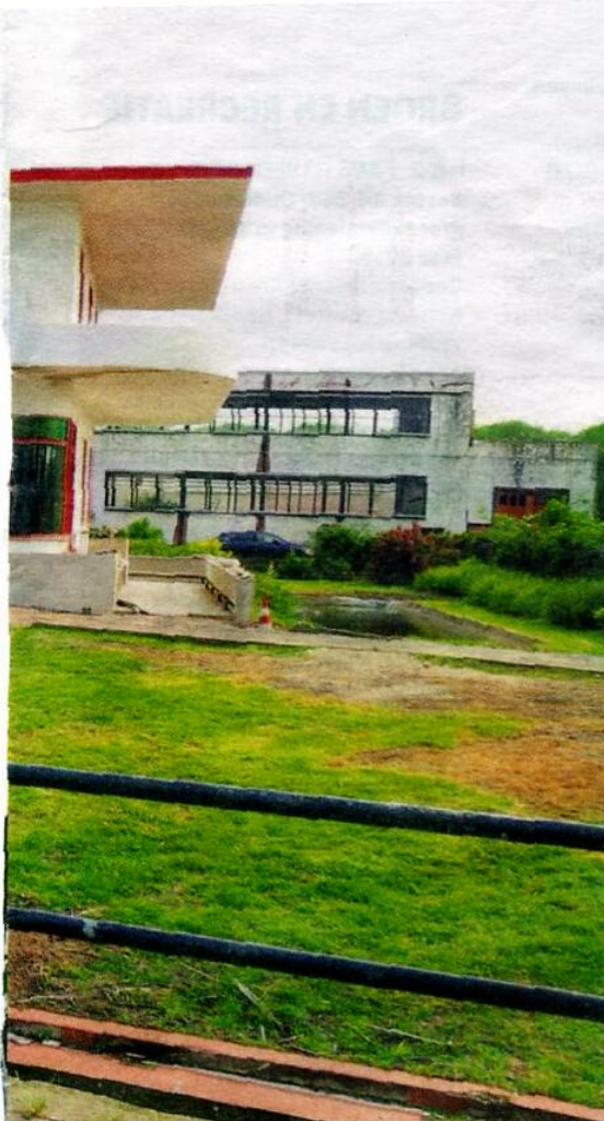
De balkons moesten worden gesloopt en vervangen, omdat ze nauwelijks hun eigen gewicht konden dragen
