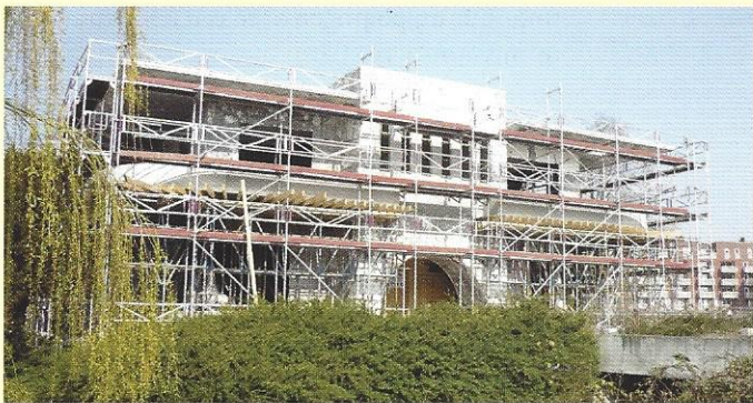
▲ In december 2009 kon begonnen worden met de restauratie van de villa.
