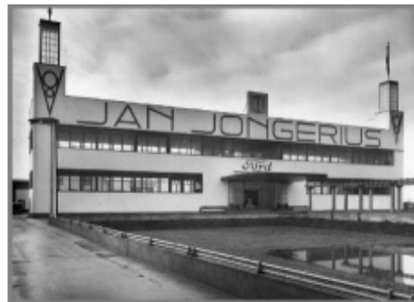
Het kantoor van het Jongeriuscomplex vlak voor de oplevering in 1937 (Foto W. ter Steege)
